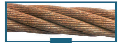
Dış korozyonun büyümüş hali
